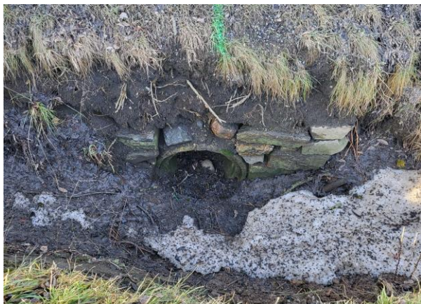
Propustek 49P – stávající vtokové a výtokové čelo
