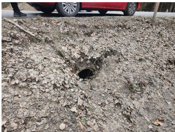
Propustek 44aP – stávající vtoková a výtaková strana
