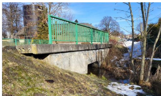
Propustek 48P – stávající vtokový a výtakový objekt
