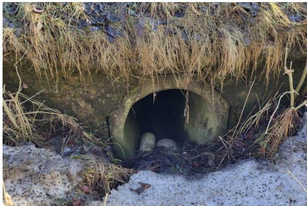
Propustek 51aP – stávající vtokové a výtokové čelo
