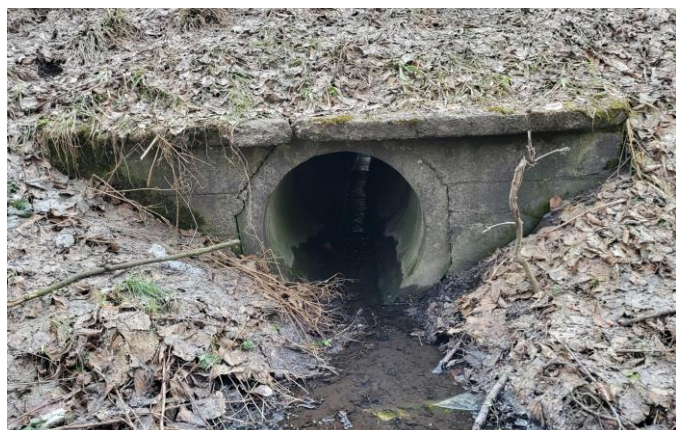
Propustek 45P – stávající vtokové a výtakové čelo
