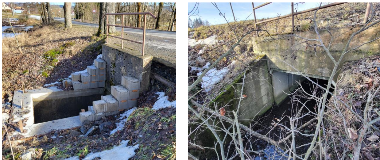
Propustek 47P – stávající vtokové a výtokové čelo
