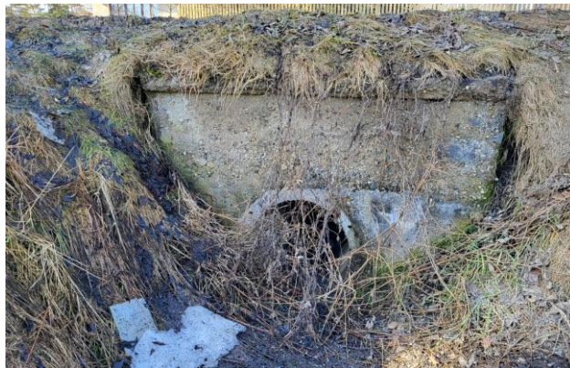
Propustek 51aP – stávající vtokové a výtokové čelo
