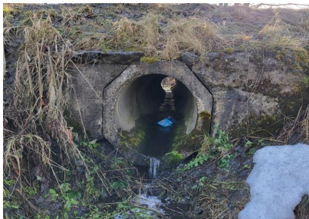
Propustek 45P – stávající vtokové a výtakové čelo
