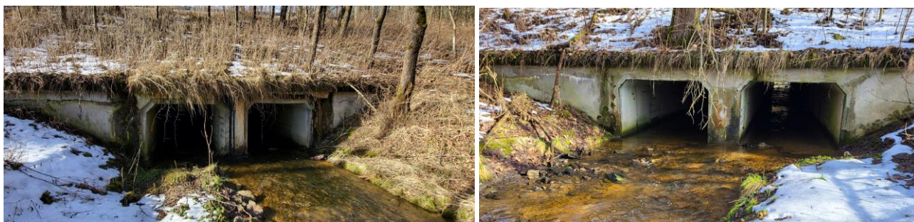
Propustek 50P – stávající vtokové a výtokové čelo
