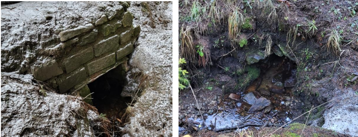
Propustek 54P – stávající vtokové a výtokové čelo
