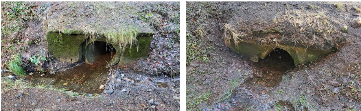
Propustek 55P – stávající vtokové a výtokové čelo
