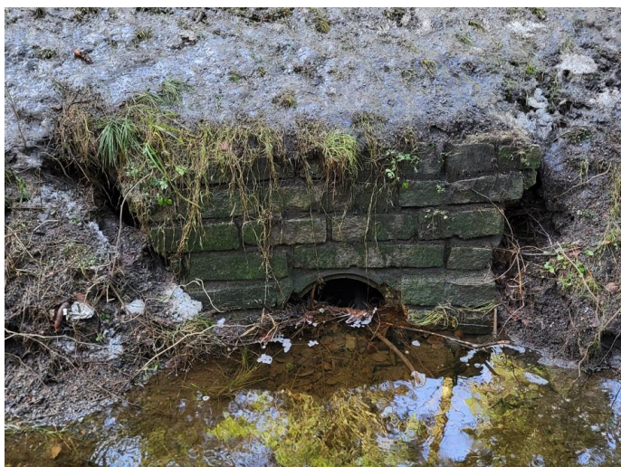
Propustek 52P – stávající vtokové a výtokové čelo
