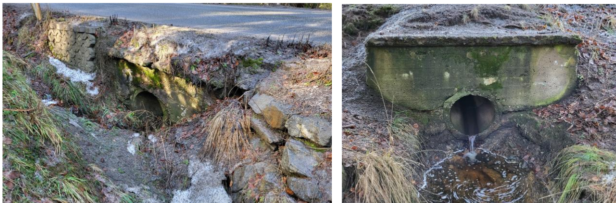
Propustek 53aP – stávající vtokové a výtokové čelo
