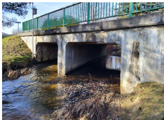
Most 010 – stávající vtokové a výtakové čelo
